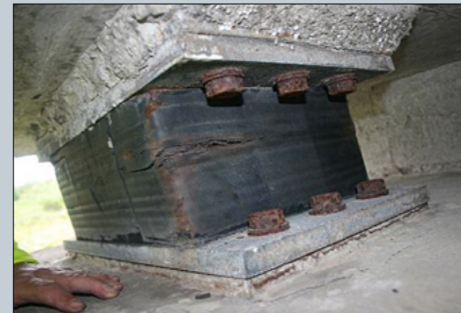
Lega í brú yfir Sogið í júlí 2014. Myndin sýnir að styrkingarplötur legunnar hafa tærst og að legan hefur orðið fyrir einhverjum skakkaföllum og þá líklega í jarðskjálftunum 2000 og 1. eða 2008.
